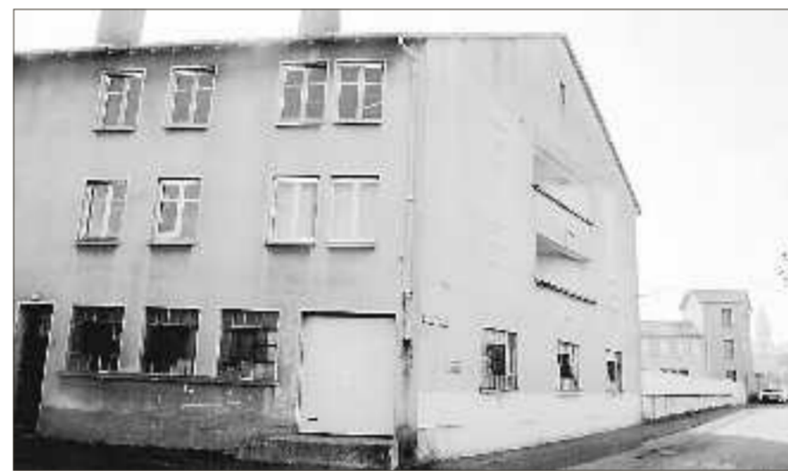
A l'étroit dans ses actuels locaux, la Sib souhaite déménager. La communauté de communes a fait un grand pas pour que l'entreprise reste à Boulay.
